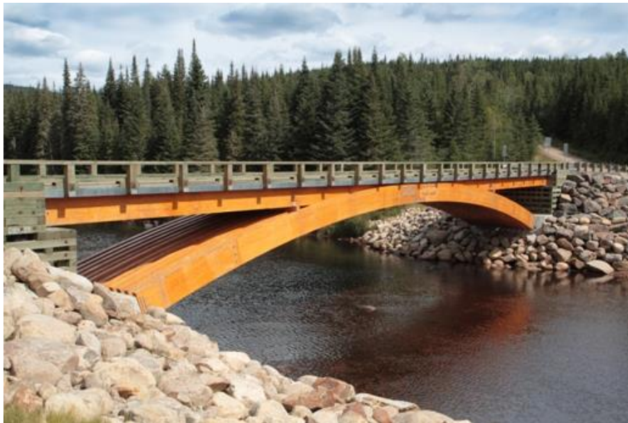
Figura 1 - Ponte localizada na floresta de Montmorency sobre o rio Montmorency, Quebec, Canadá. Possui vão de 44 m, altura de 33 m e largura de 4,8 m [3].
